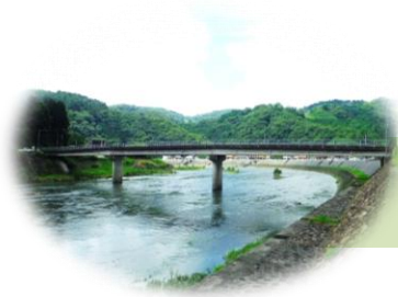
昭和橋 (美咲町久木)
