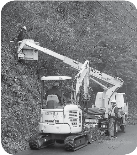
支障木伐採は大変だ!
