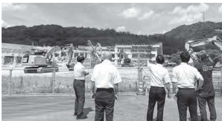
柵原西小学校の解体現場視察
