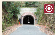
⑥ 峠清水トンネル
