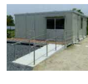
休憩所・トイレの整備
