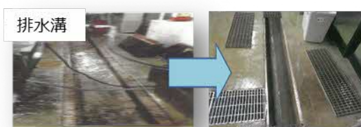
施設の衛生管理の強化に向 けた排水溝、床、壁等の改修
