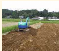
土層改良（客土）
