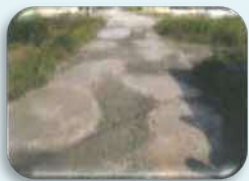
農道の窪みの補修
