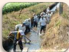
水路の泥上げ
