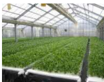
農業生産施設 （水耕栽培ハウス）
