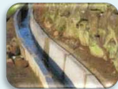
コンクリート水路の更新
