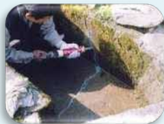
水路のひび割れ補修
