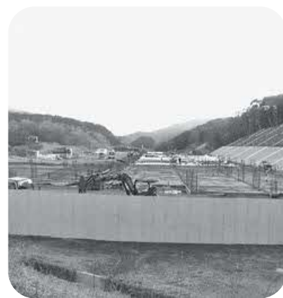
着々と進む建設工事
