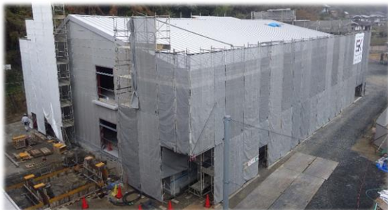
工事中の増築棟（外部）
