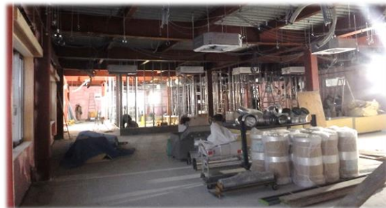
工事中の増築棟（内部）
