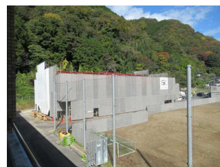
【建設中の増築棟】
