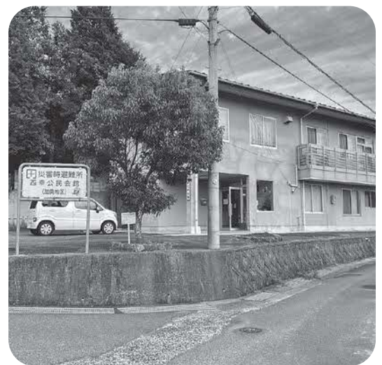
老朽化が進む公民館
