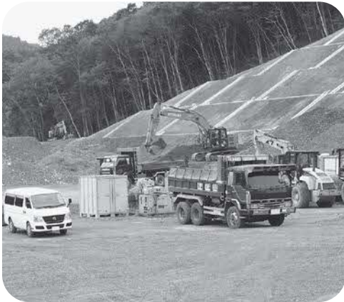
着々と進む建設工事
