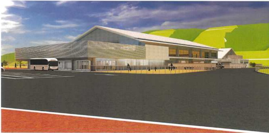
エントランス南東
