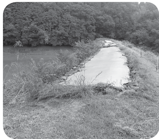
安全対策が確認できた飯岡滝谷池
