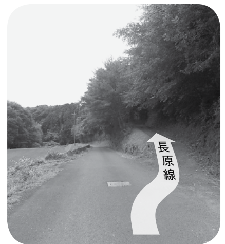
整備が待たれる町道長原線 (新城地内)
