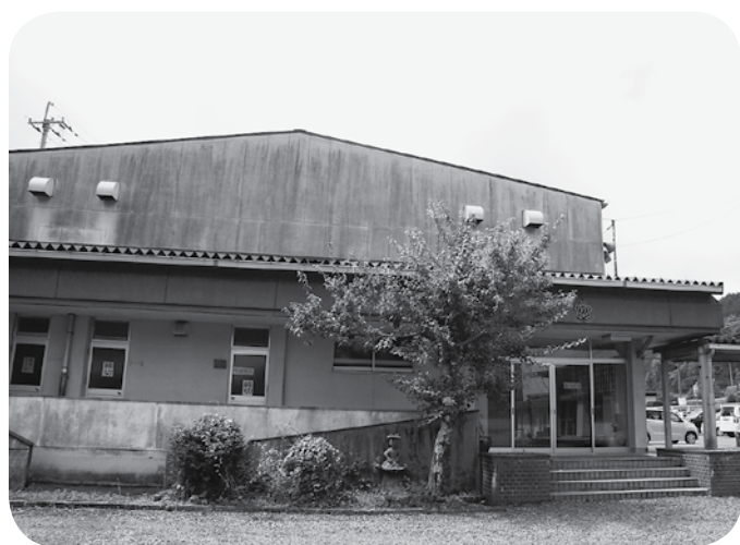
利用しやすい公共施設に (旧打穴小学校体育館)
