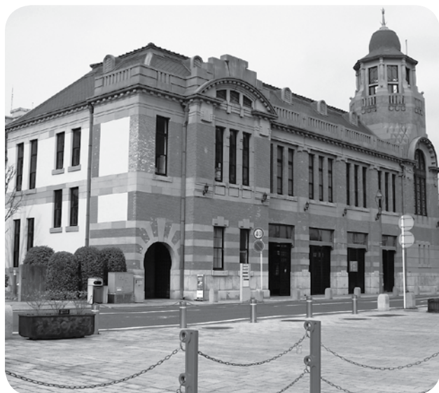
大正6年に建築された大阪商船門司支店を修復した旧大阪商船ビル
