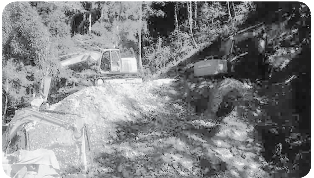
命を守る砂防工事（栃原地内）
