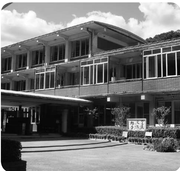
改修工事が始まる旭小学校
