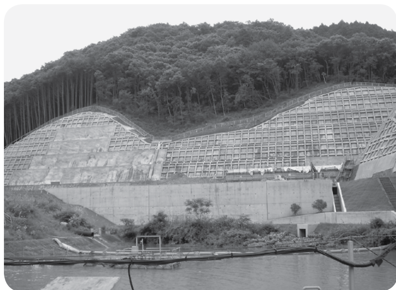
工事が進む新処理施設（吉ヶ原地区）
