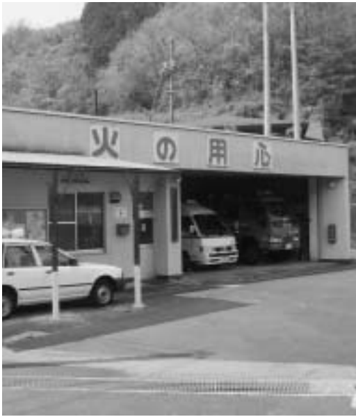
地域を守る津山圏域消防組合（柵原出張所）
