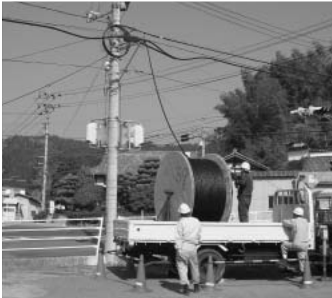
光ファイバの敷設工事中（打穴中地内）
