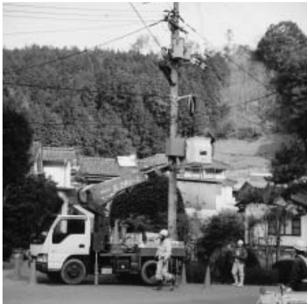
急ピッチで進む敷設工事(西川上地区)
