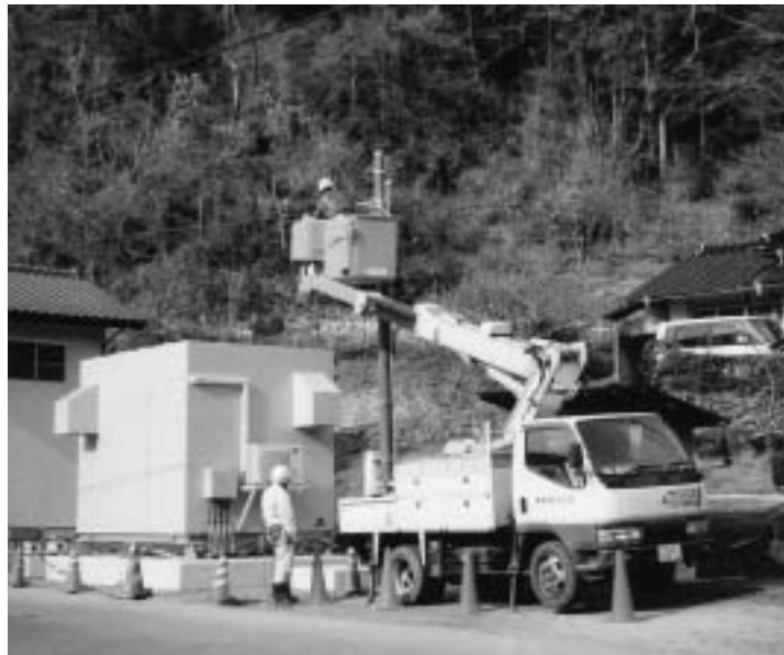
みさきネット完成へ 休日返上(西川上地内)
