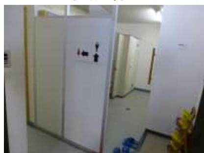
■センター便所（男女共用入口）
