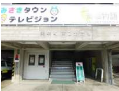
■第二分庁舎出入口
