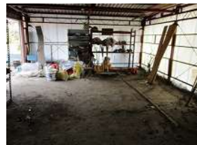
柵原No61 倉庫
