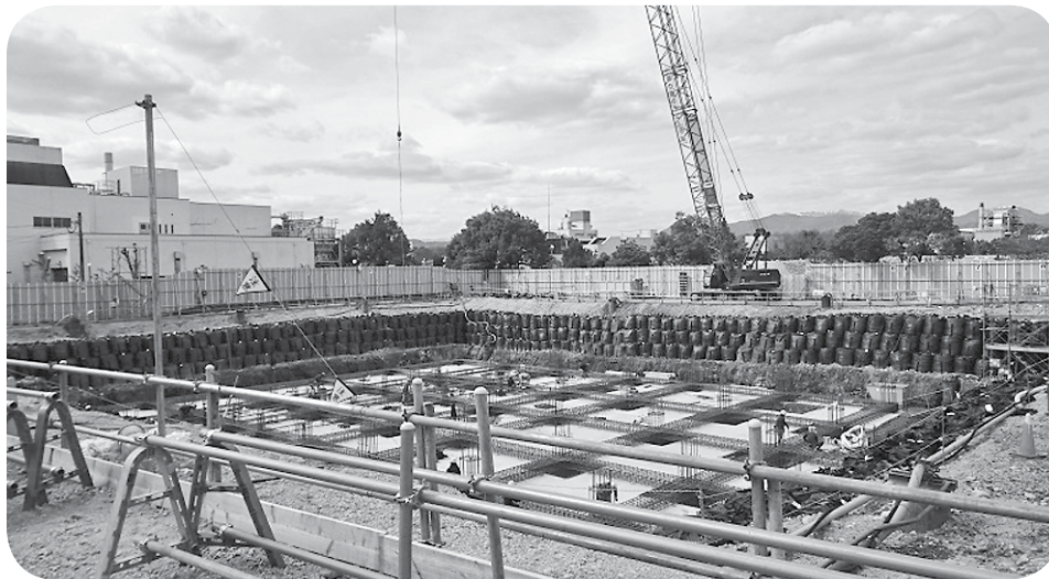
津山市川崎へ建設中の汚泥再生処理センター (津山圏域衛生処理組合)
