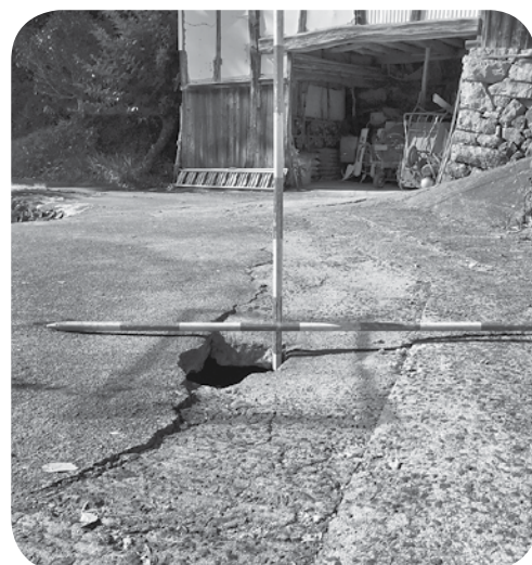
急げ！道路修繕
