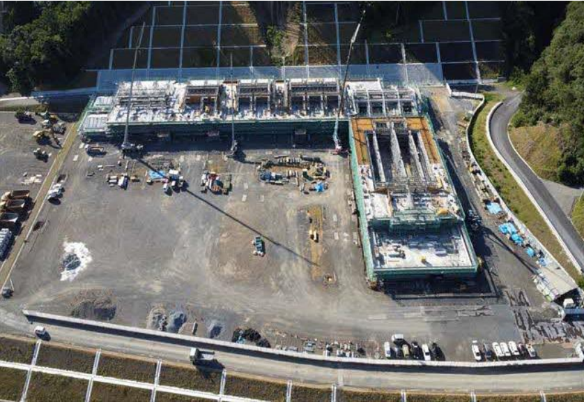
建築工事の状況 (R5.7末現在)
