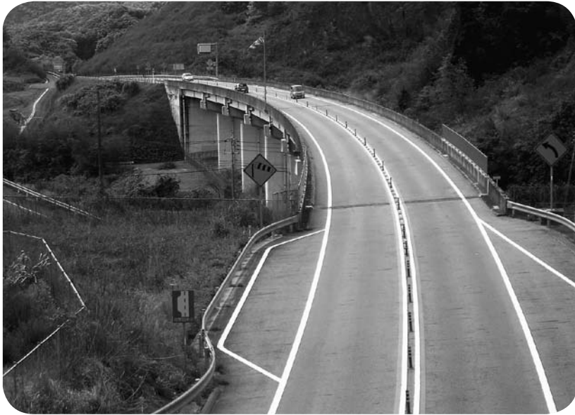
通行が開始された美作岡山道路佐伯～熊山間
