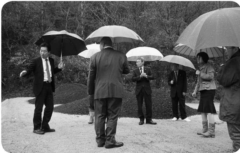
もうすぐ埋立てが完了する最終処分場（柵原クリーンセンター）
