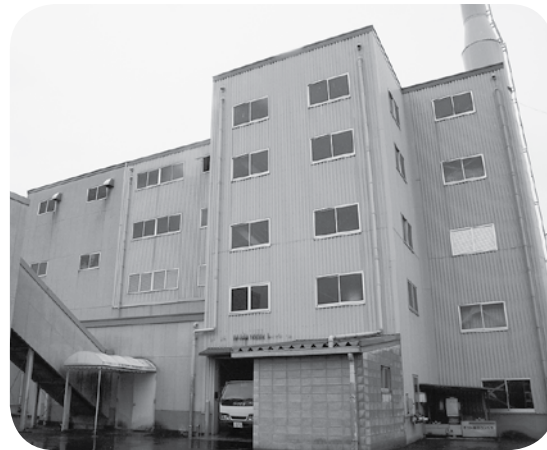
まもなく役割を終えるゴミ処理施設 (津山西部清掃センター)
