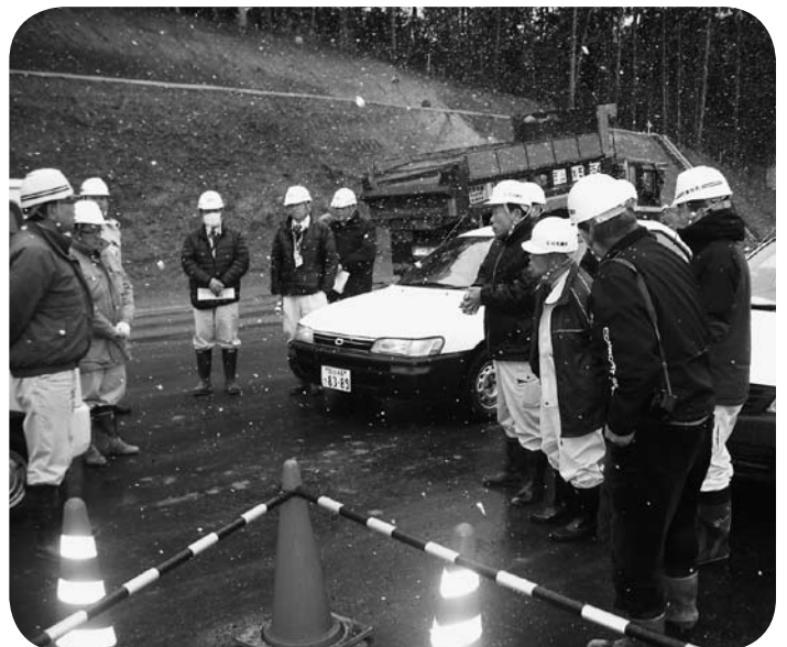
着々と工事が進む津山クリーンセンター
