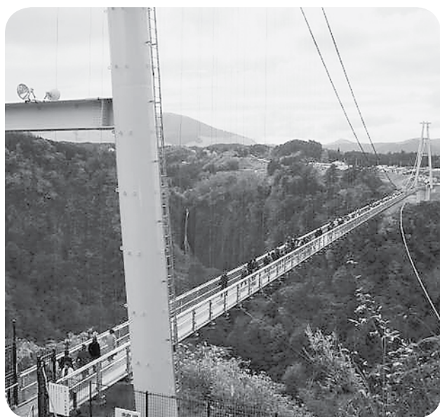
600万人が渡った夢大吊り橋（九重町）
