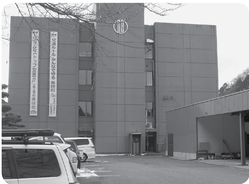
変わる旭総合支所周辺（みち停建設予定地）
