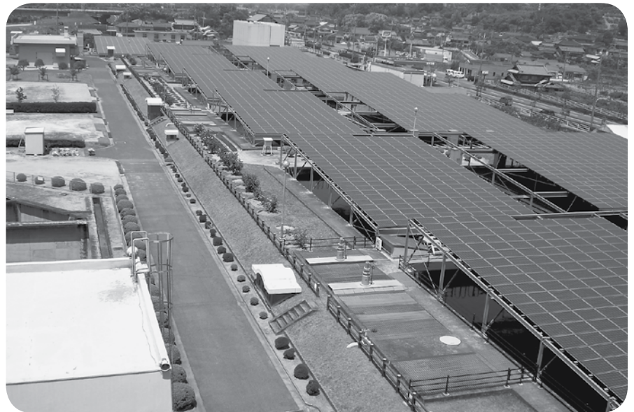
美咲町でもクリーンエネルギーの活用を（倉敷市西之浦浄水場の太陽光パネル）
