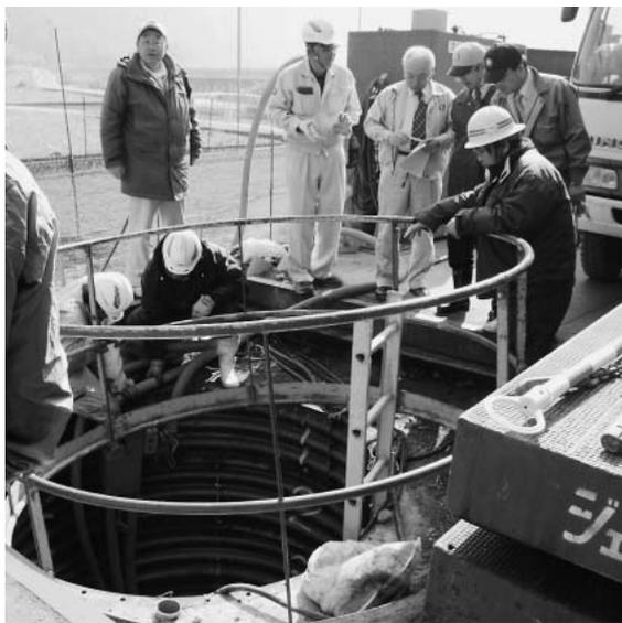
推進工法による管路埋設工事中の柵原公共下水道(吉ヶ原地内)
