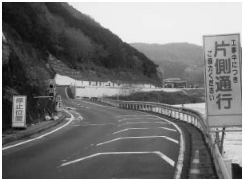
整備が進む吉井川右岸(久木)
