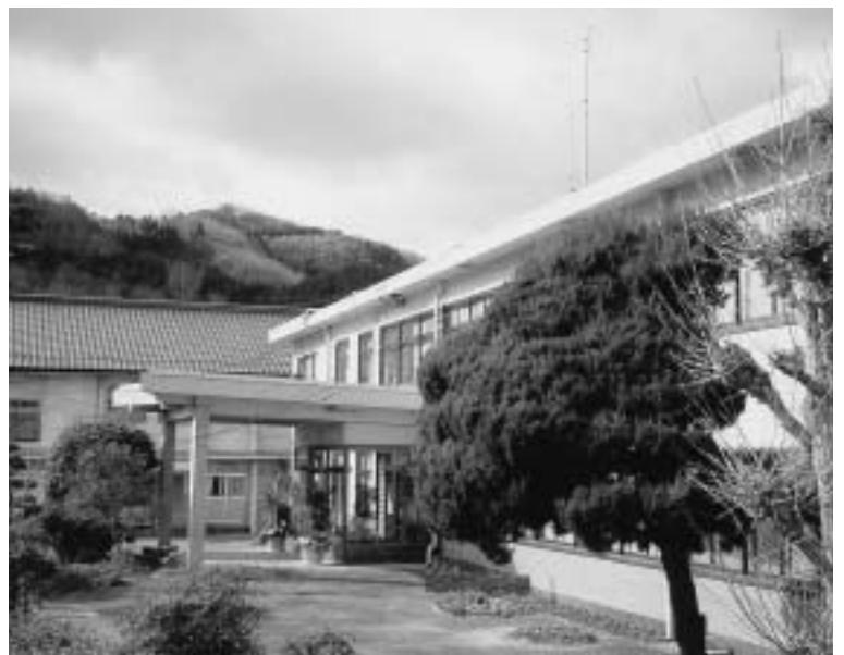
建て替えが望まれる柵原総合支所(久木)
