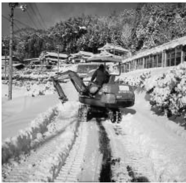
12月降雪 各業者により除雪が行われた(大井和西)
