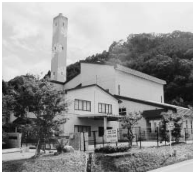
コスモスクリーンセンター（中部環境施設組合 真庭市宮地）
