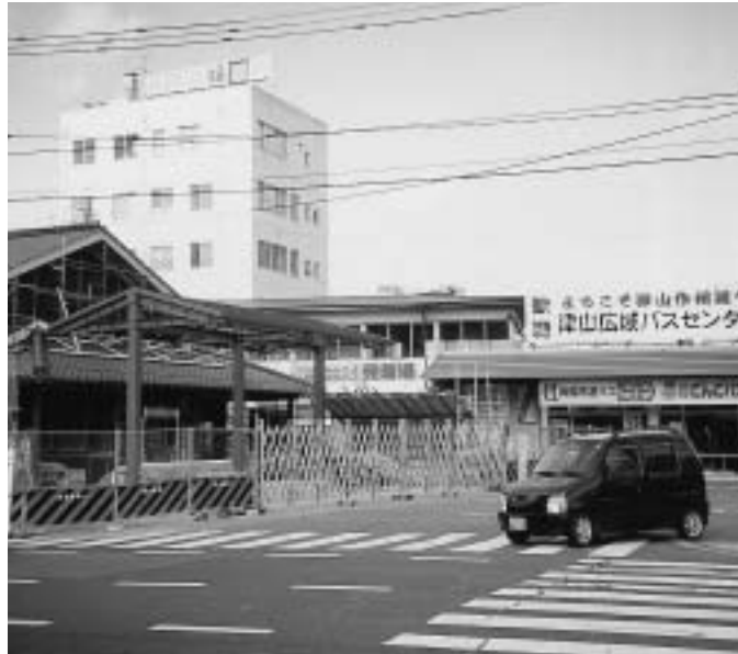
工事が始まった広域バスセンター（JR津山駅前）
