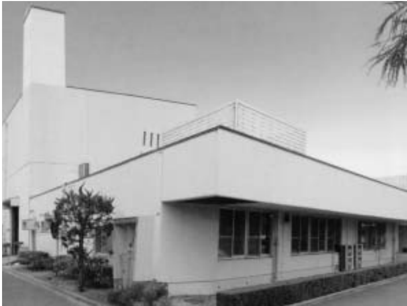
津山圏域衛生処理組合処理場(津山市川崎)
