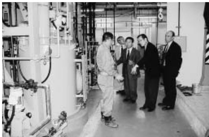
最終処分場の廃水処理現場（江与味地区）
