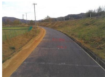
農道舗装（王子地区）
