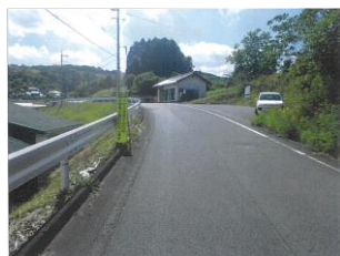
区画線設置前
