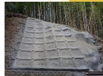
法面对策（町道祖母中央線）
