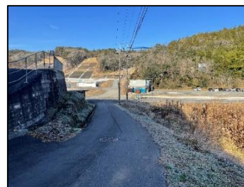
整備前（道路拡幅予定）
