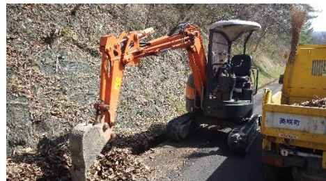
委託業者による側溝清掃作業
