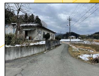
整備前（待避所設置予定）
