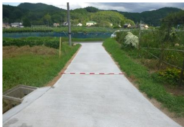
道路補修資材支給事業による生コン舗装
