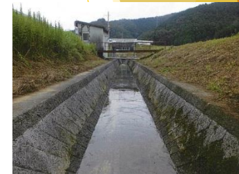
土砂取り除き後
